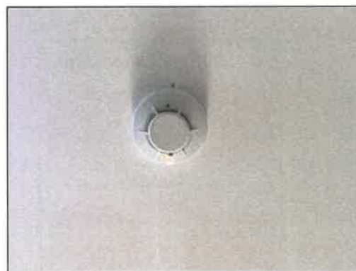
รูปที่ 2-29 เครื่องตรวจจับควัน
