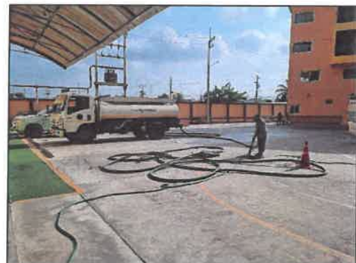
รูปที่ 2-11 ผู้รับเหมามาสูบน้ำจากตะกอนออกจากบ่อเมื่อบ่อเกรอะเต็ม
