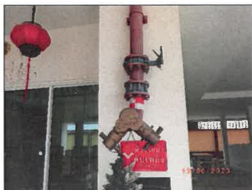
รูปที่ 2-26 หัวรับน้ำดับเพลิงภายนอกอาคาร
