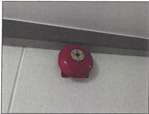
รูปที่ 2-30 กริ่งสัญญาณเตือนอัคคีภัย
